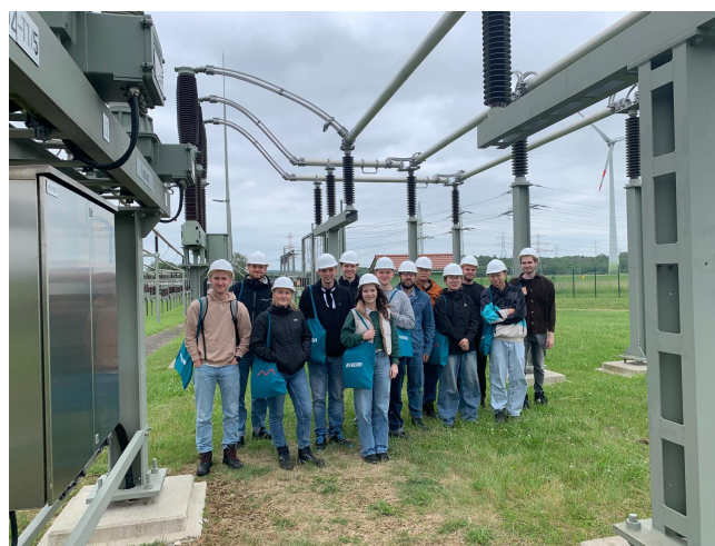
(b) Besichtigung des Umspannwerks
